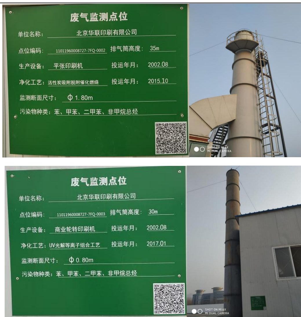
附图 8 有组织 VOCs 废气排气筒
