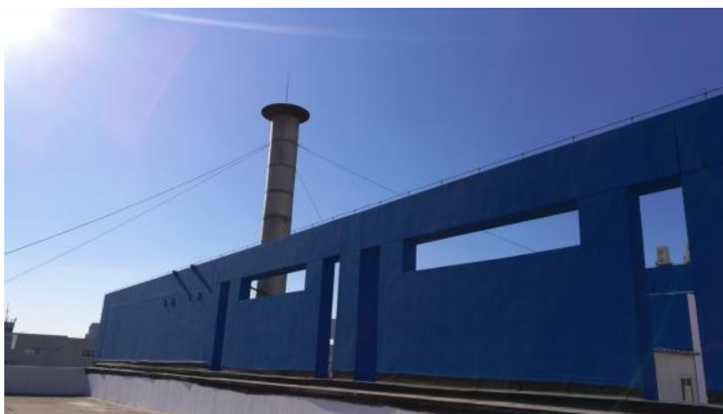
附图9 轮转机烘干设备排气筒
